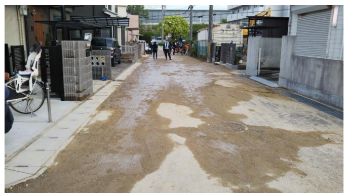
道路舗装の上に広がった土砂。 乾燥すると砂埃が飛散。
