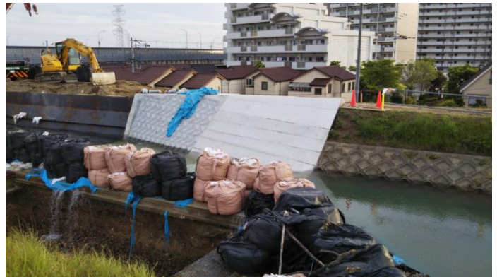
護岸工事のため、川幅が大幅に減少
