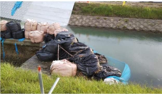
土嚢の高さが護岸の高さより低い？
